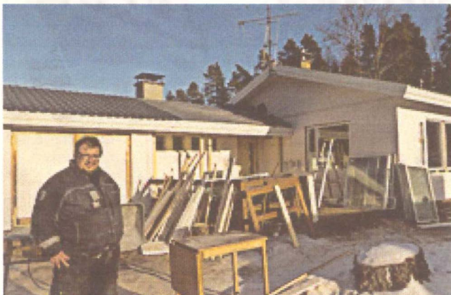
Tässä Heinolassa sijaitsevassa kohteessa suoritettiin kokonaisvaltainen korjausremontti.
